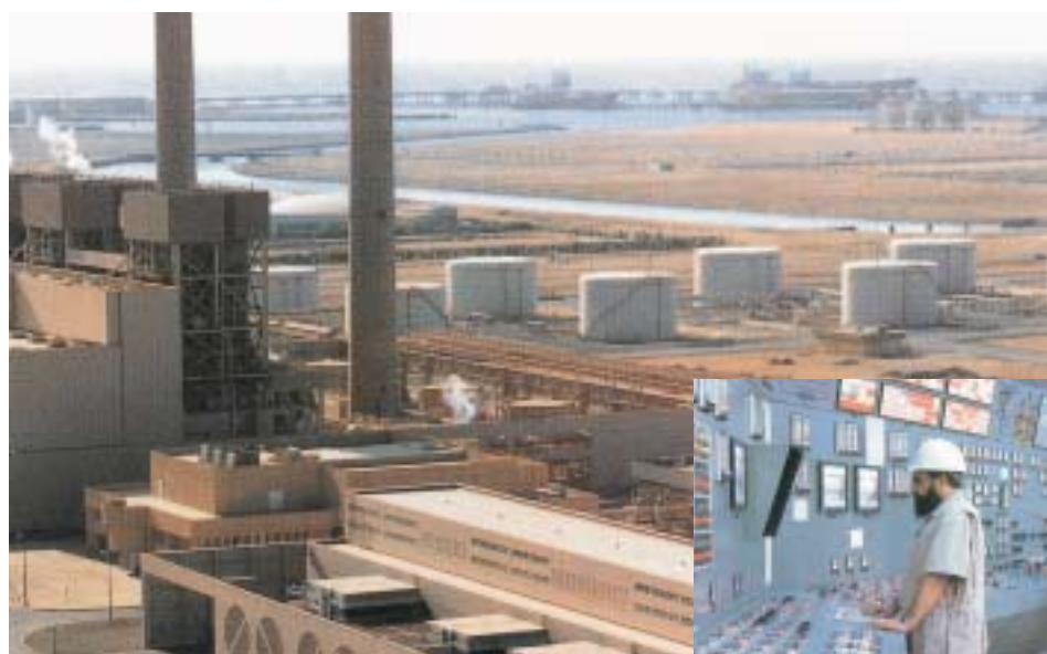
発電・造水プラント
