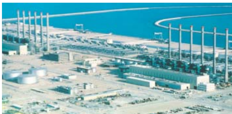
造水プラント (ジュベイル)
