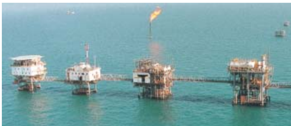
カフジ油田の沖合集油施設
