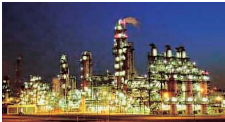
SHARQのプラント（ジュベイル）
